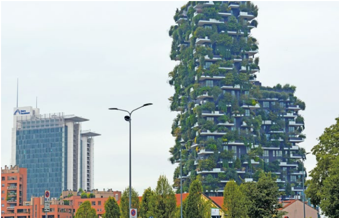
Abb. 2: Wohnturm „Bosco Verticale“ in Mailand (Foto: Annick Rietz)
